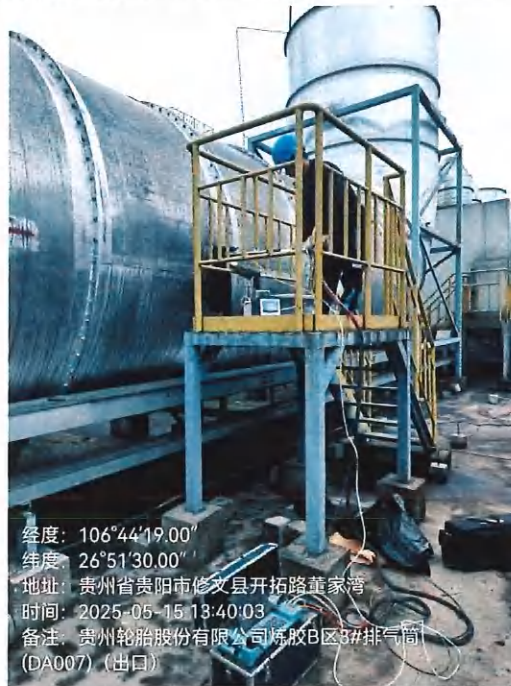
有组织废气现场检测图片 (炼胶B区3#排放口(DA007))
