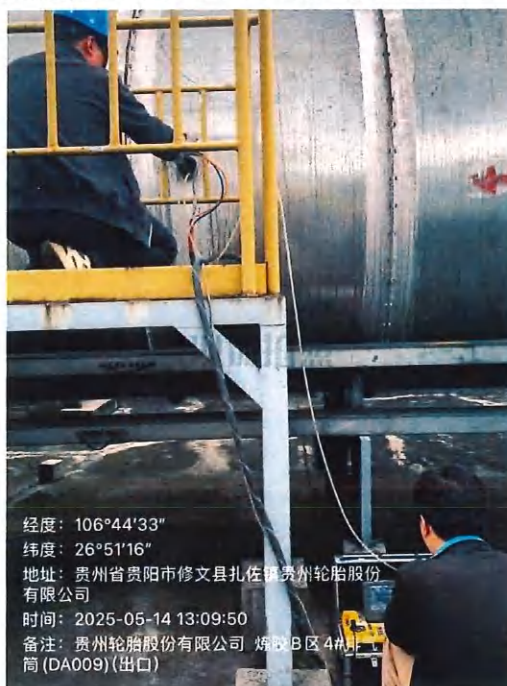
有组织废气现场检测图片(炼胶B区4#排放口(DA009))
