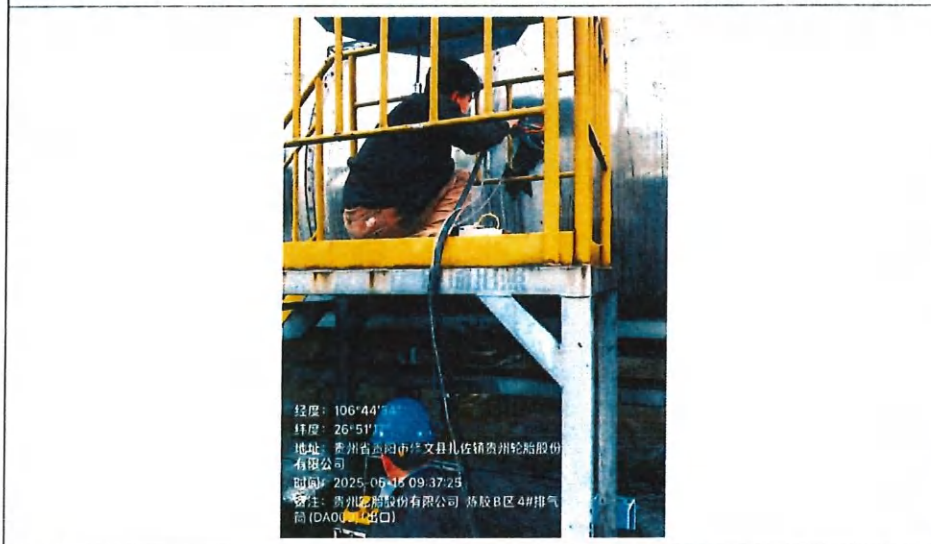
有组织废气现场检测图片（炼胶B区4#排气口(DA009)（出口））
